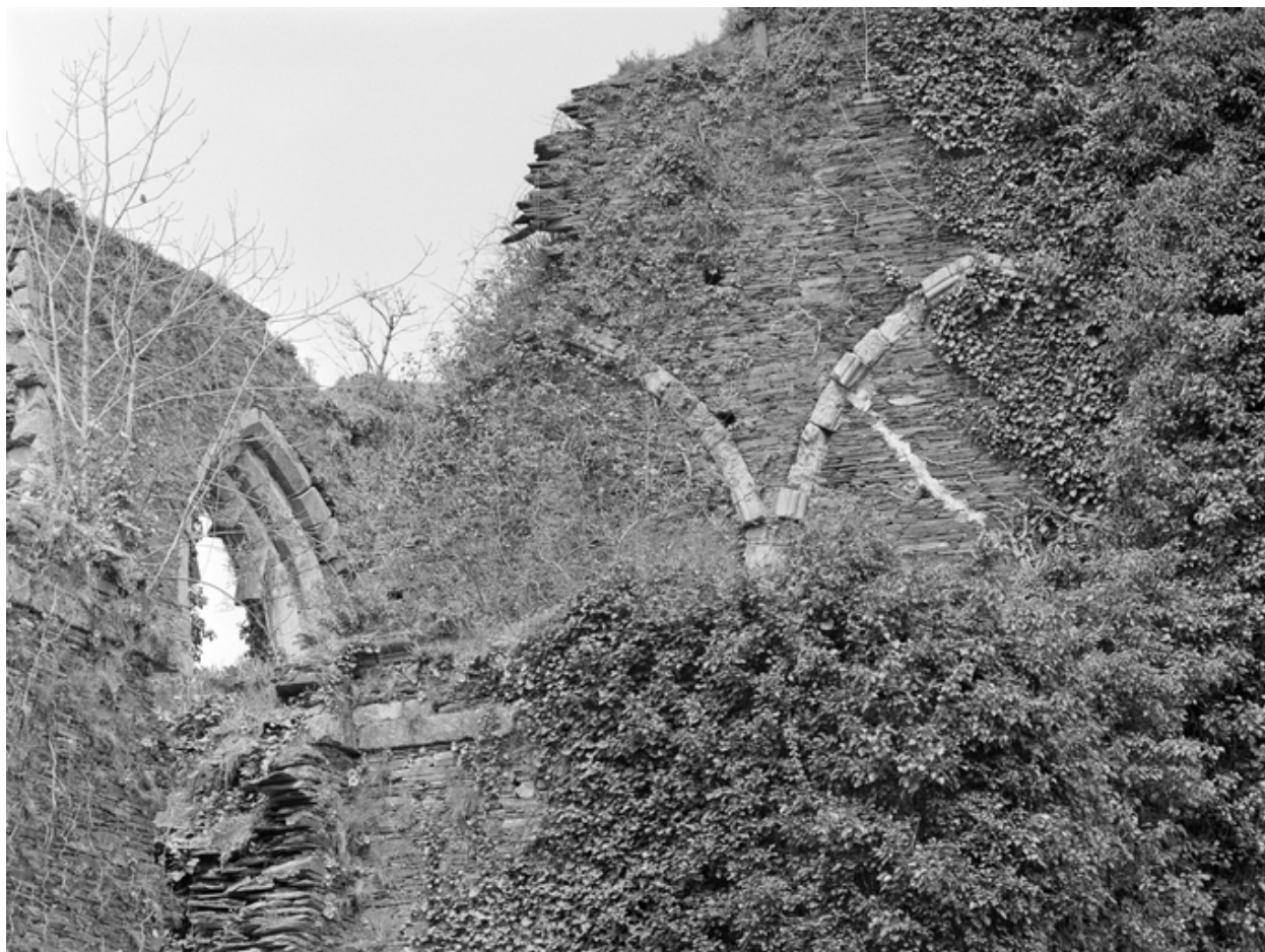
Abbatiale, bras Sud du Transept : arcades murées (état en 1977).
