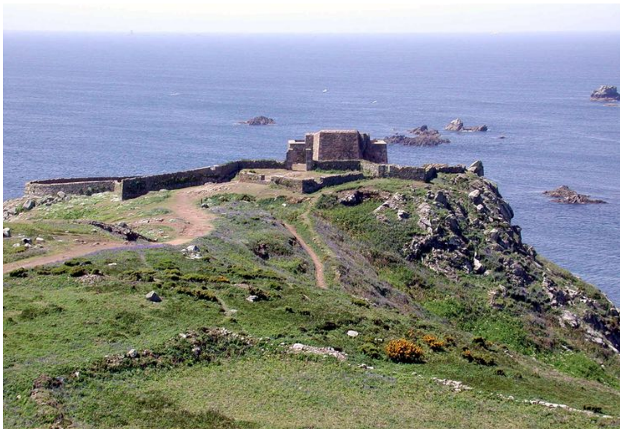
Vue d'ensemble du fort et de la redoute, réduit de l'île aux Moines
