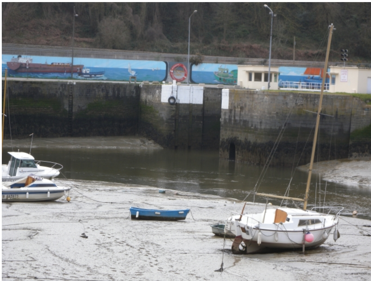
Vue des portes de l'écluse du bassin à flot et du quai rive droite
