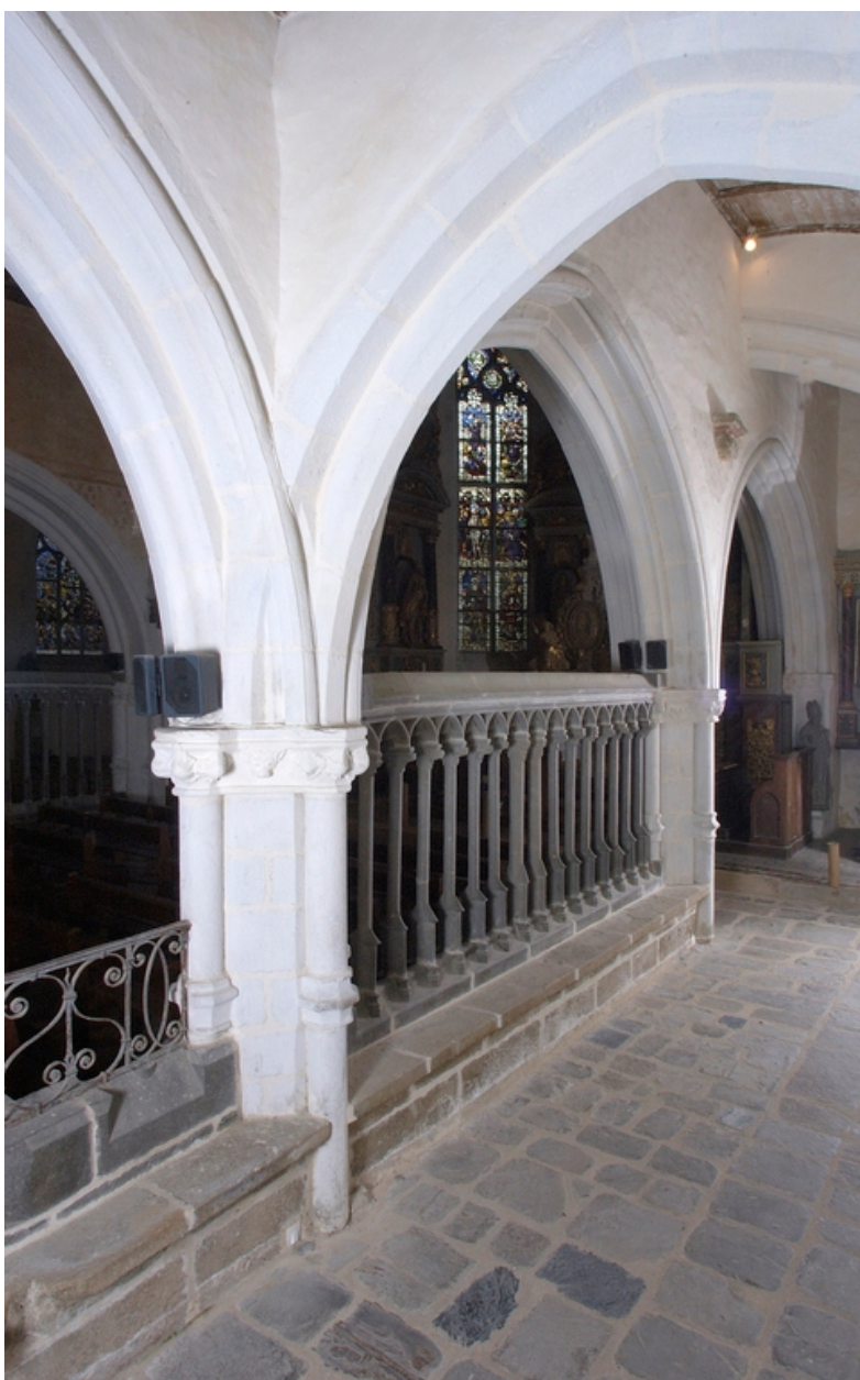
Vue de détail d'un pilier de la nef
