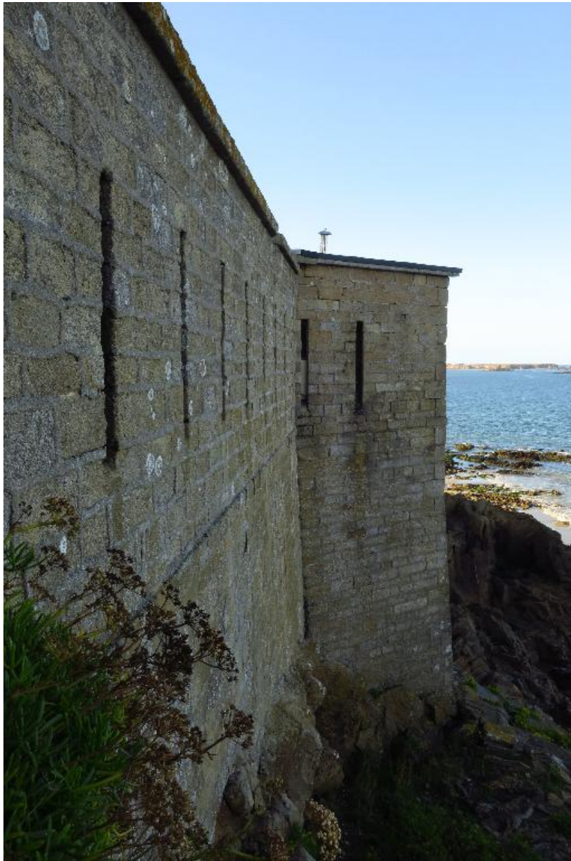
Saint-Pierre-Quiberon, fort de Penthievre, enceinte, escarpe du réduit.
