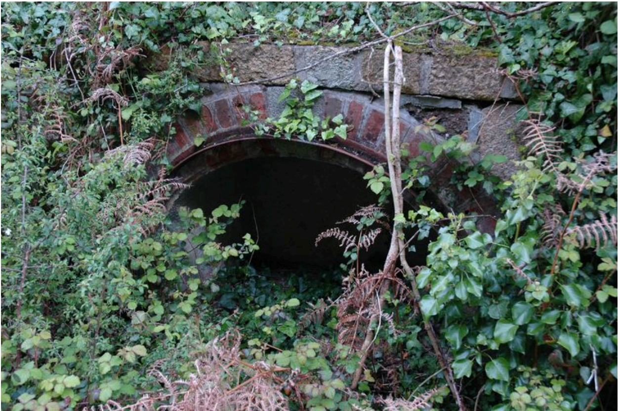
Vue de la pointe des Espagnols : niche à munitions (19e siècle) aménagée dans le parapet de la batterie basse
