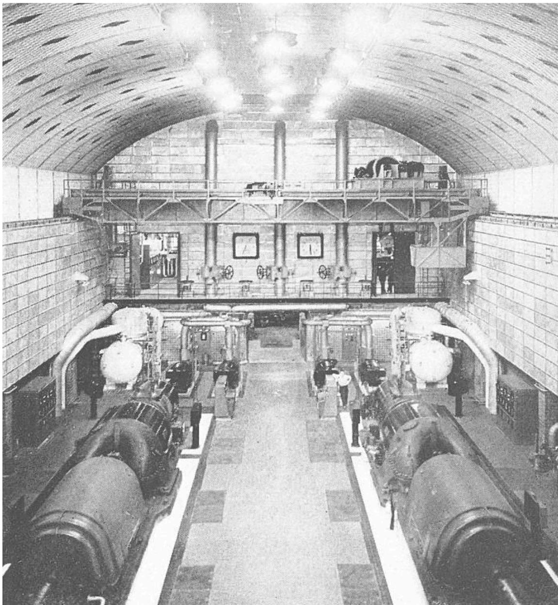
Vue de la salle des machines dans l'alvéole principale : ensemble de deux turbo-alternateurs, 1953
