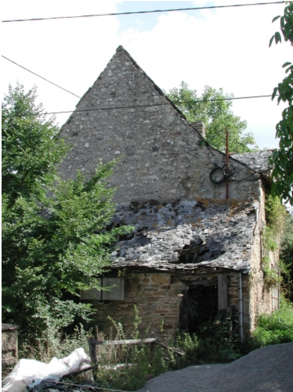
La ferme : ancien logis ruiné, vue du pignon est
