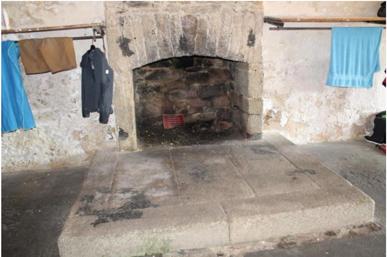
Grande cheminée d'une casemate
