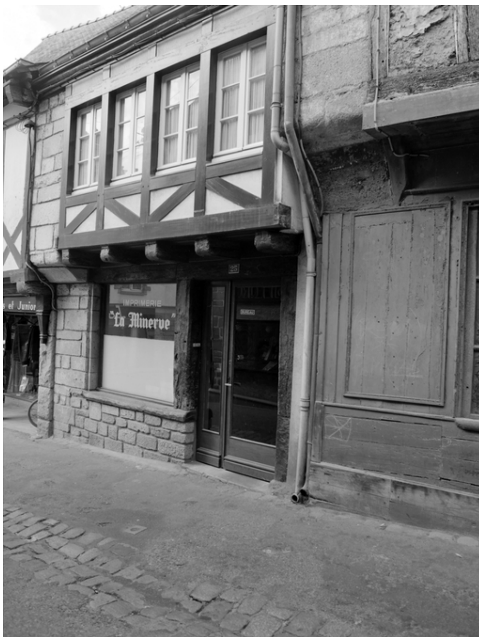
25 rue du Pont, vue générale de la façade.
