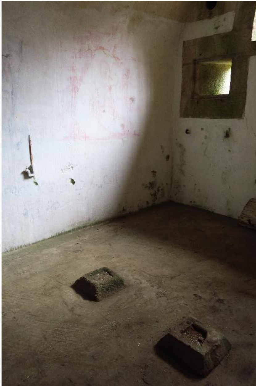
Archipel de Glénan, batterie de Penfret, corps de garde crénelé, plots de poteaux de supports de hamacs.
