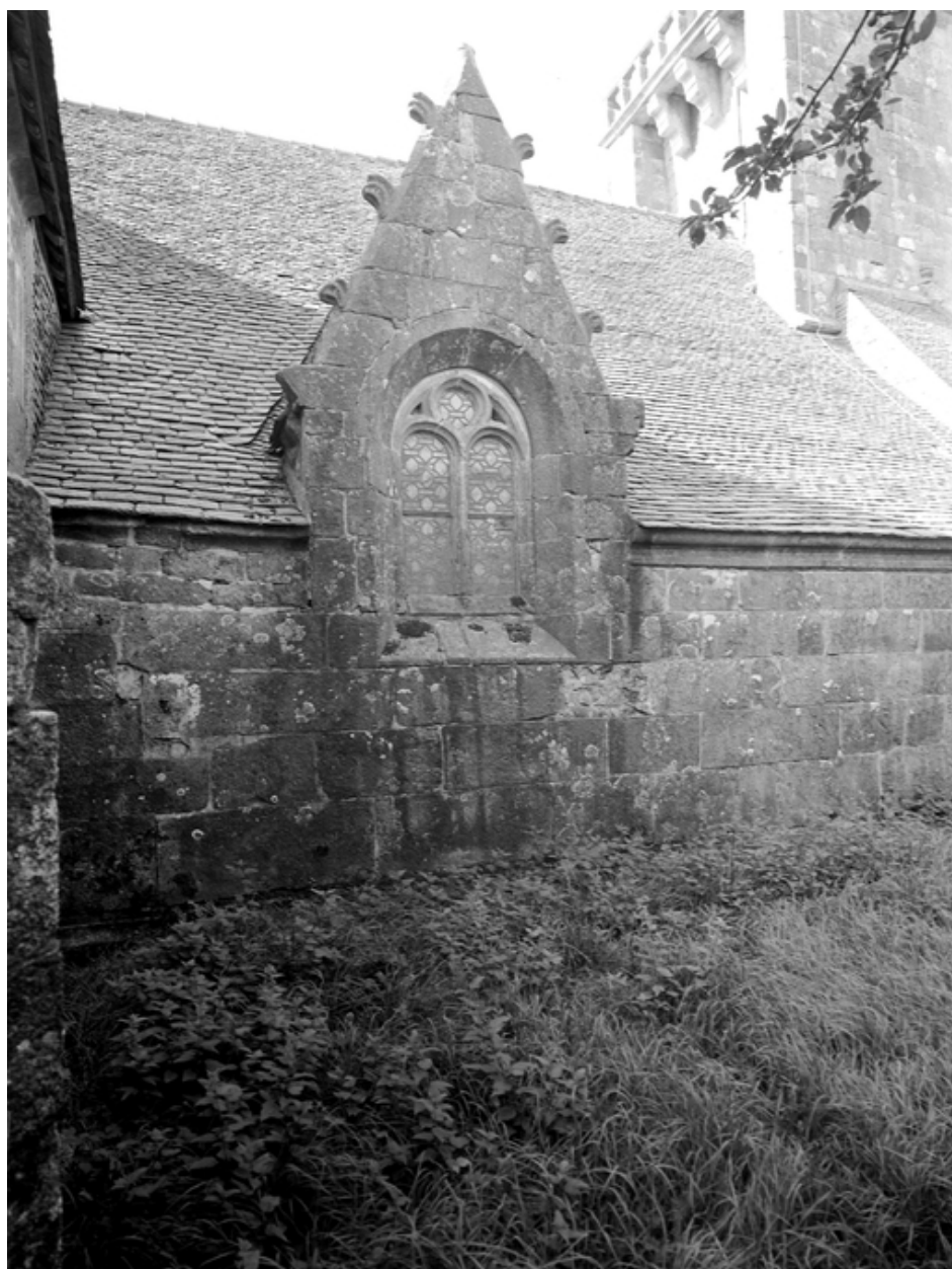
Fenêtre du mur nord du bas-côté nord
