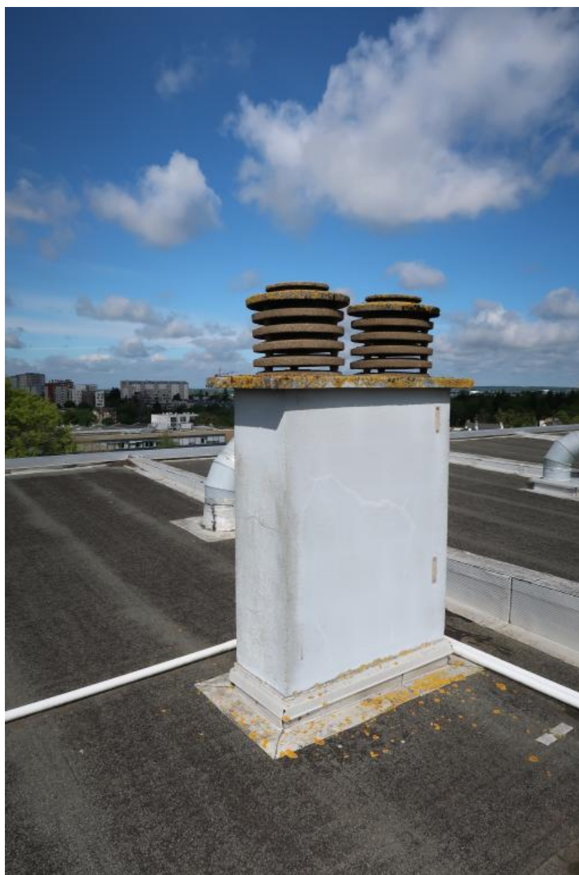
Cheminée sur l'internat (G).
