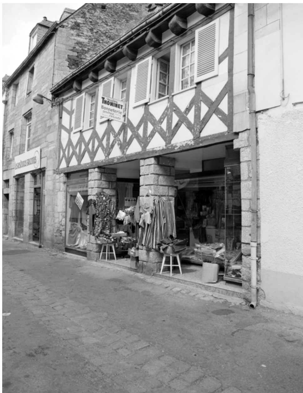
29 rue du Fil, vue générale.
