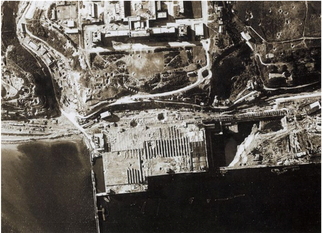
Vue aérienne verticale du Stützpunkt U-Bootbunker (base de sous-marins). A droite de la base de sous-marins : les fondations de l'extension est
