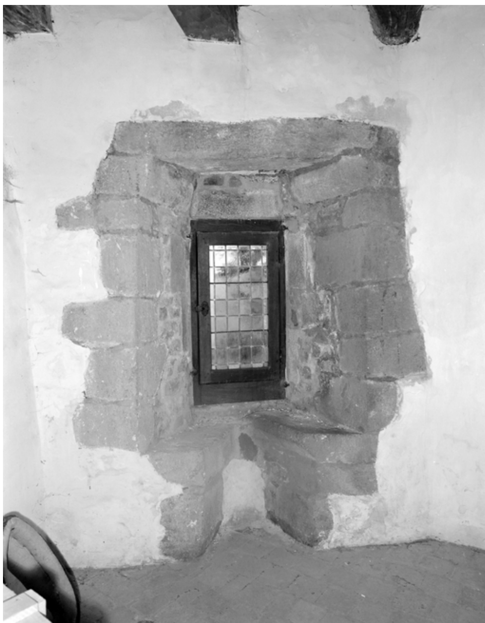
Vue d'une petite fenêtre à coussièges au premier étage (état en 1974)
