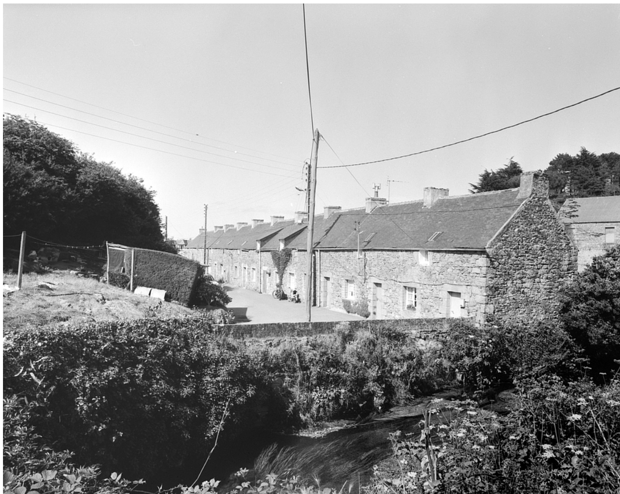
Maison d'ouvriers, vue générale sud-ouest
