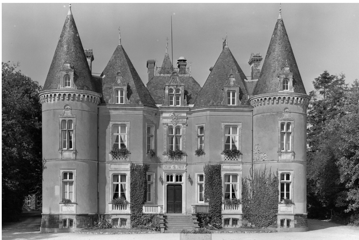
Vue générale du château.
