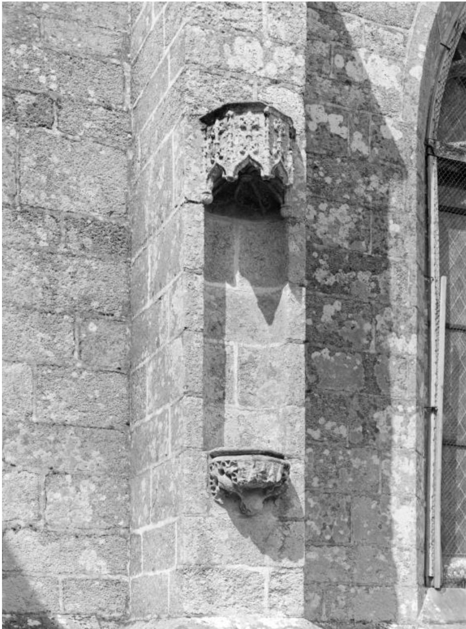
Niche du contrefort médian du mur sud du choeur.
