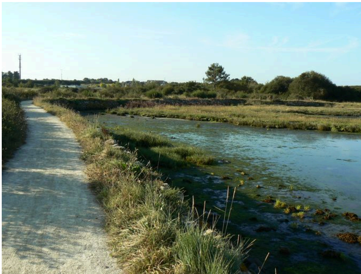
Digue-route dite le Pont Lisse
