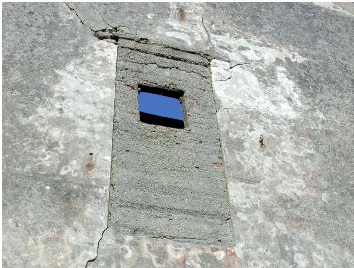
Vue d'une embrasure bétonnée aménagée au premier étage (état en 2003)
