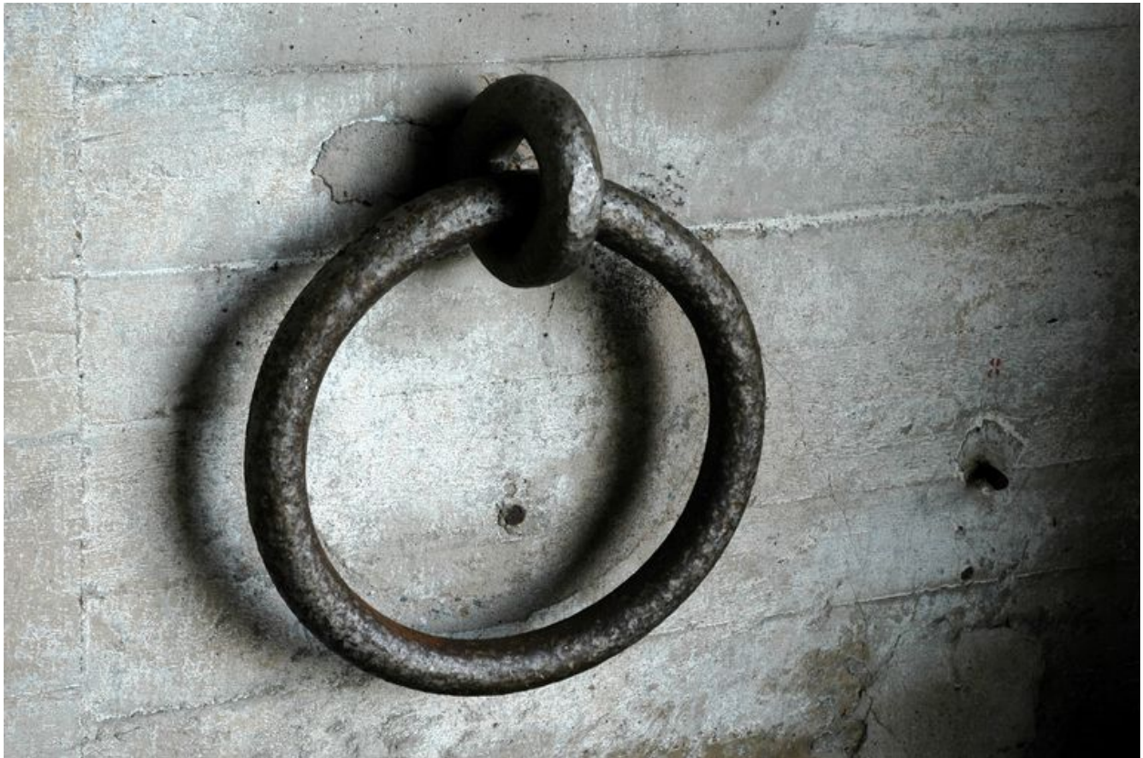
Vue de l'intérieur de la base de sous-marins : organeau pour l'arrimage du sous-marins dans l'alvéole
