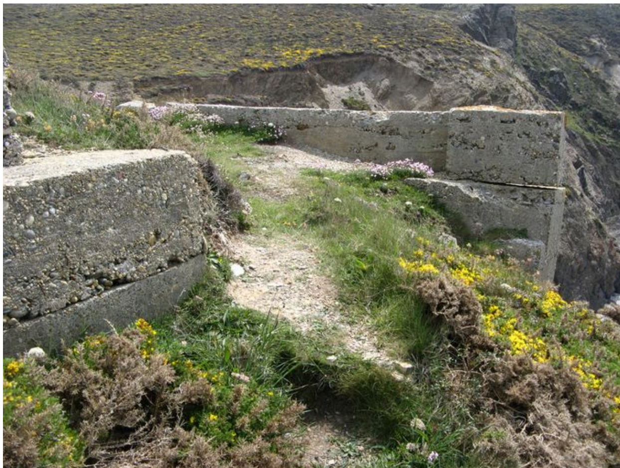
Poste de chargement de galets
