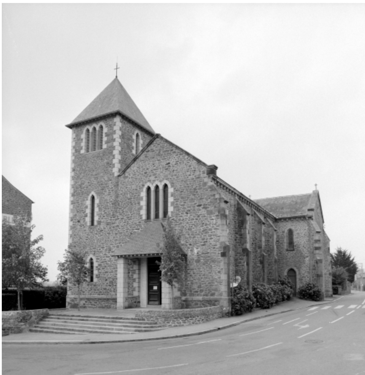
Elévation Ouest : vue générale
