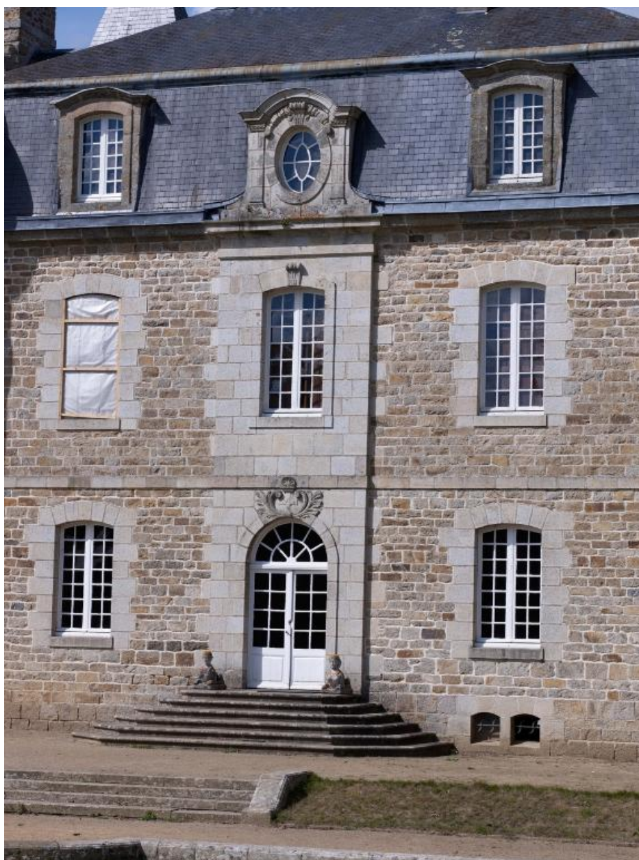
Vue de l'élévation orientée vers le sud-est : détail de la travée centrale
