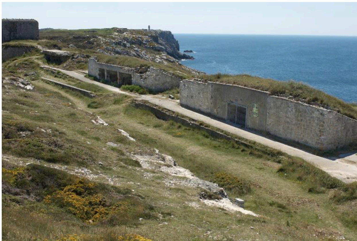
Vue de la batterie de mortier
