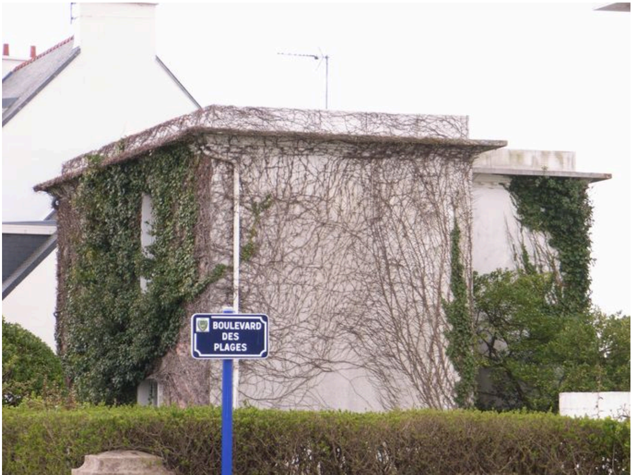
Façade nord de la villa Les Bleuets
