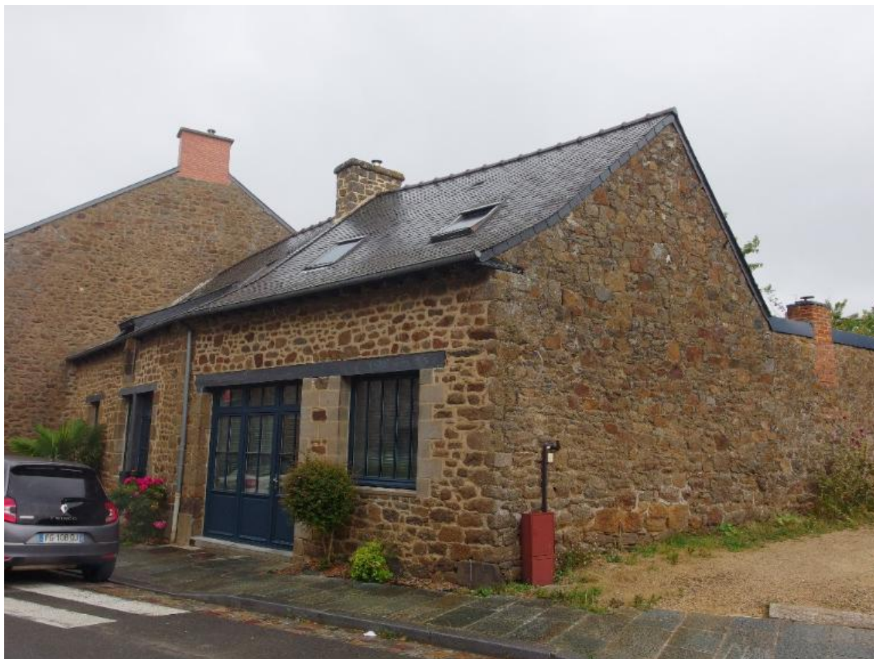
Vue de la façade ouest et sud
