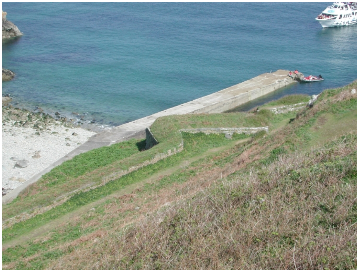
Vue en plongée du quai et des murs de retranchement
