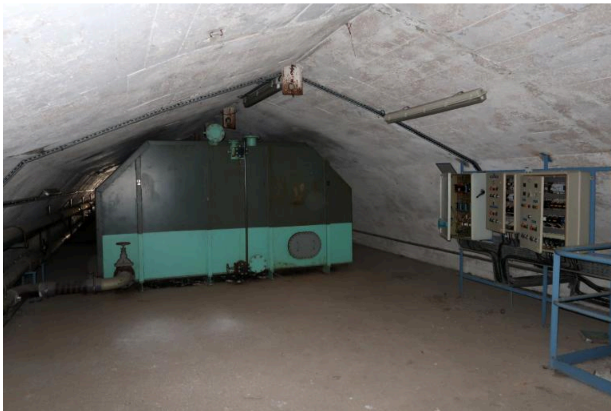
Quatrième étage (cinquième niveau) : grande cuve métallique à eau
