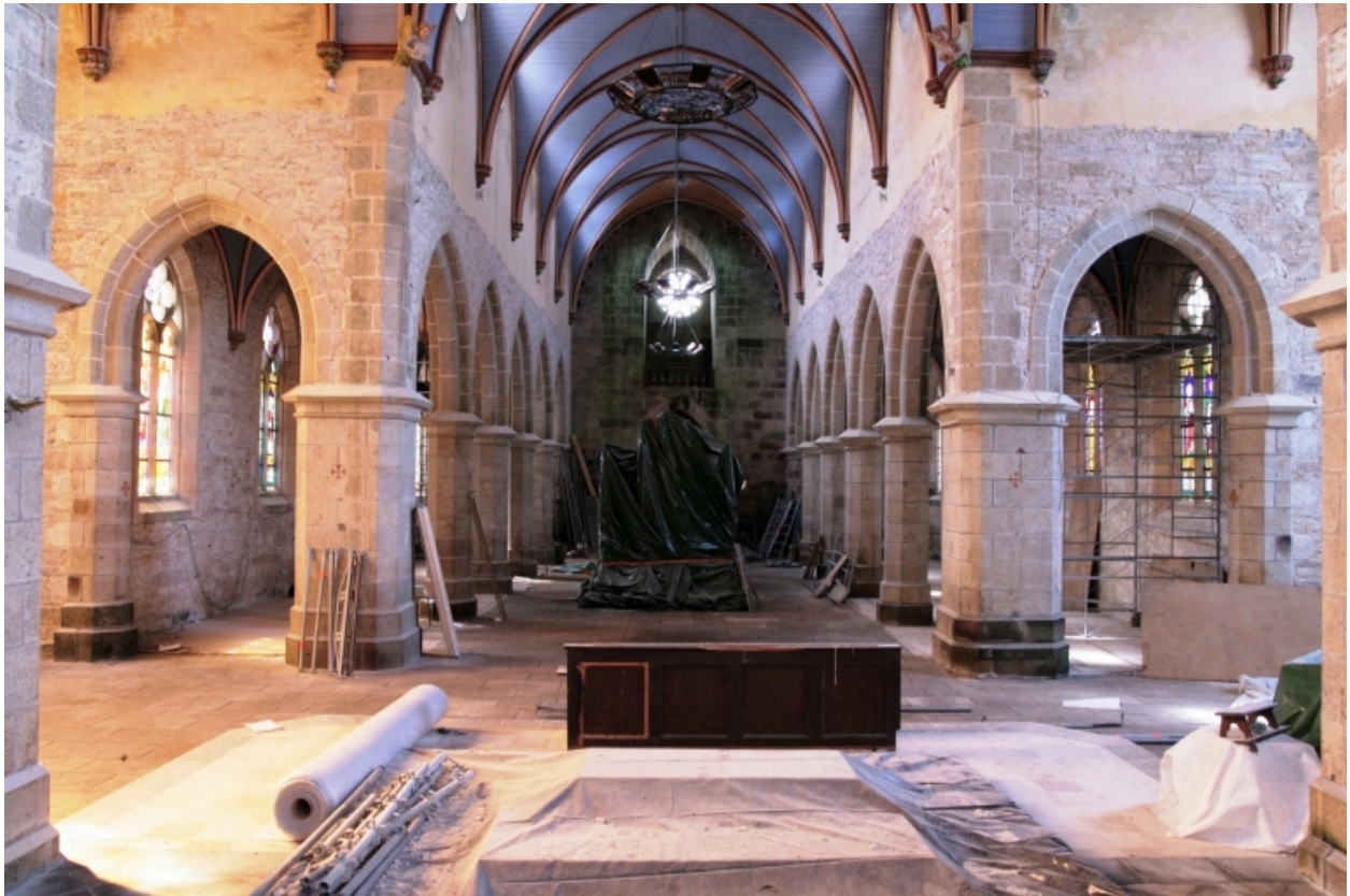
Hanvec, église paroissiale Saint-Pierre : vue axiale ouest
