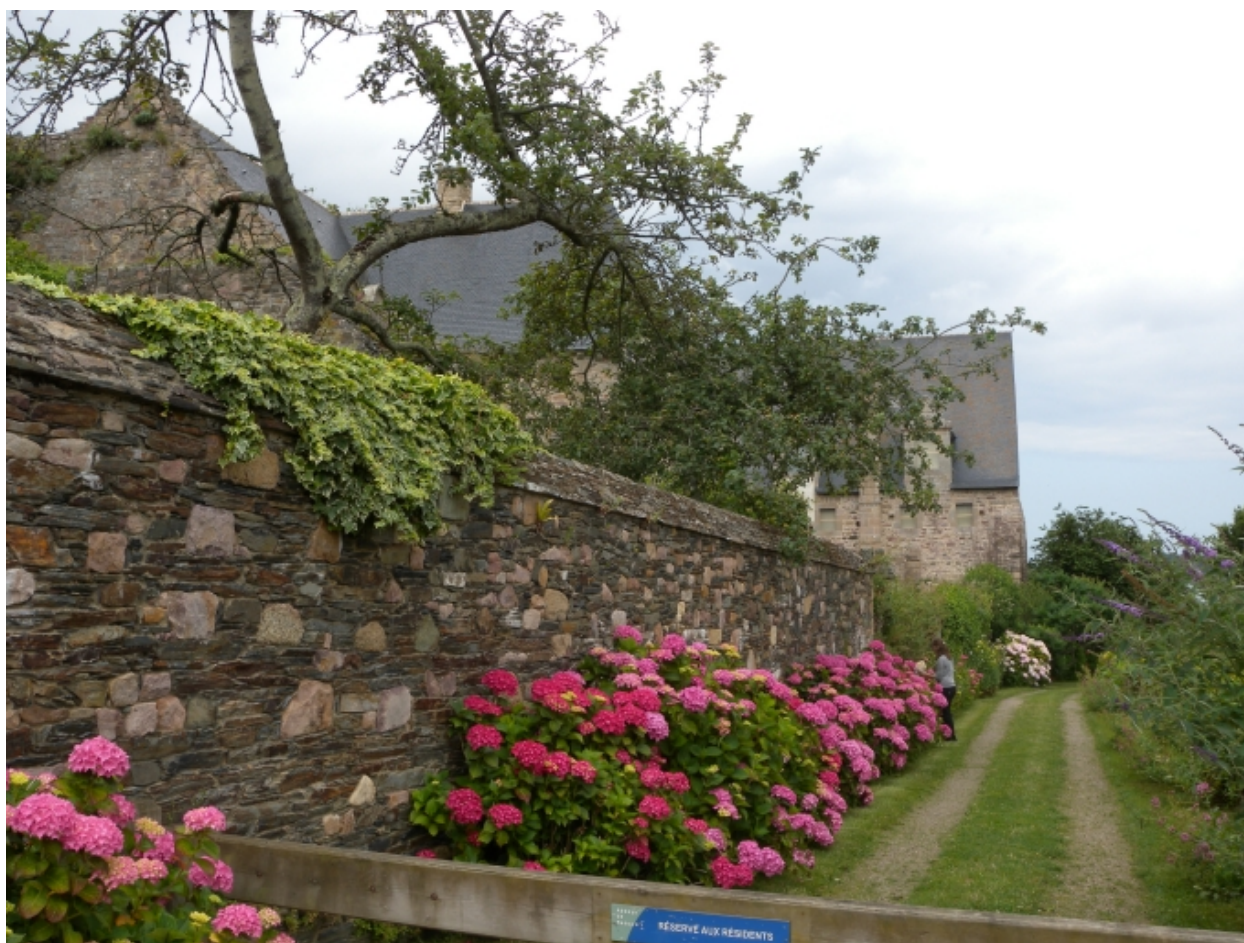
Vue du mur d'enceinte Est de l'église
