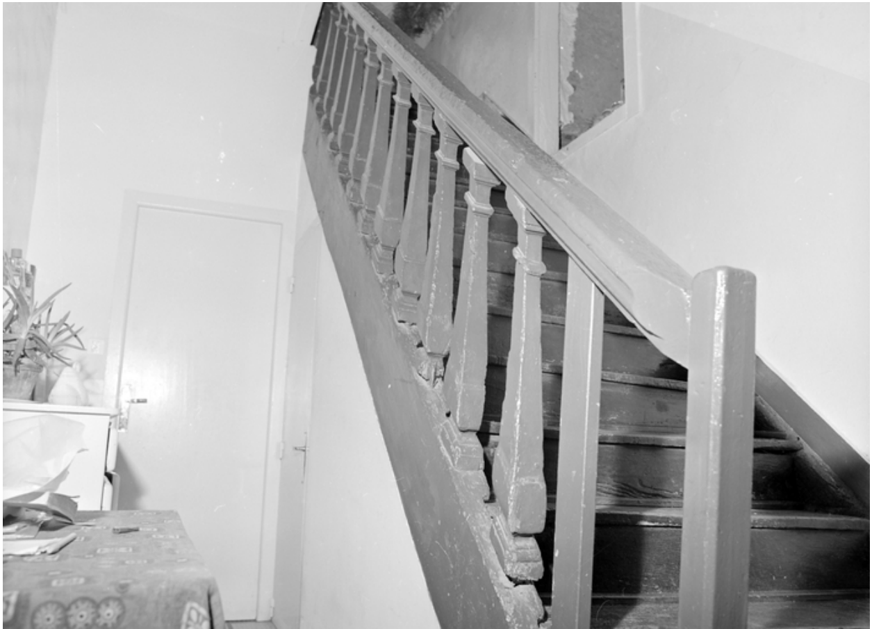
Maison 3 place de la Mairie, escalier entre 1er et 2e étage.
