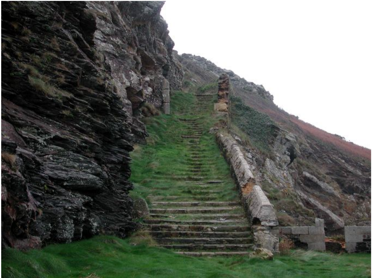
Vue de la batterie de Cornouaille : grands escaliers aménagés le long de la falaise (fin 17e siècle - début 18e siècle)
