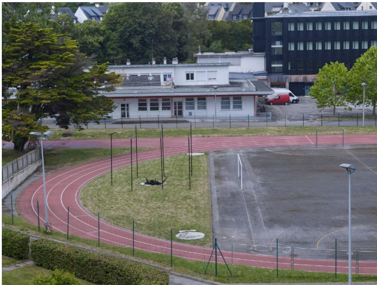
Le bâtiment de la restauration scolaire (avec logements au premier étage) et le bâtiment B, façades sud-est. Vue prise des étages d'un internat.
