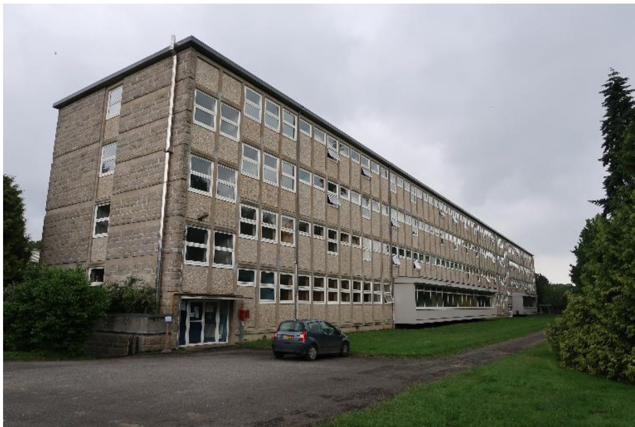
Internat : bâtiment I, façade ouest.
