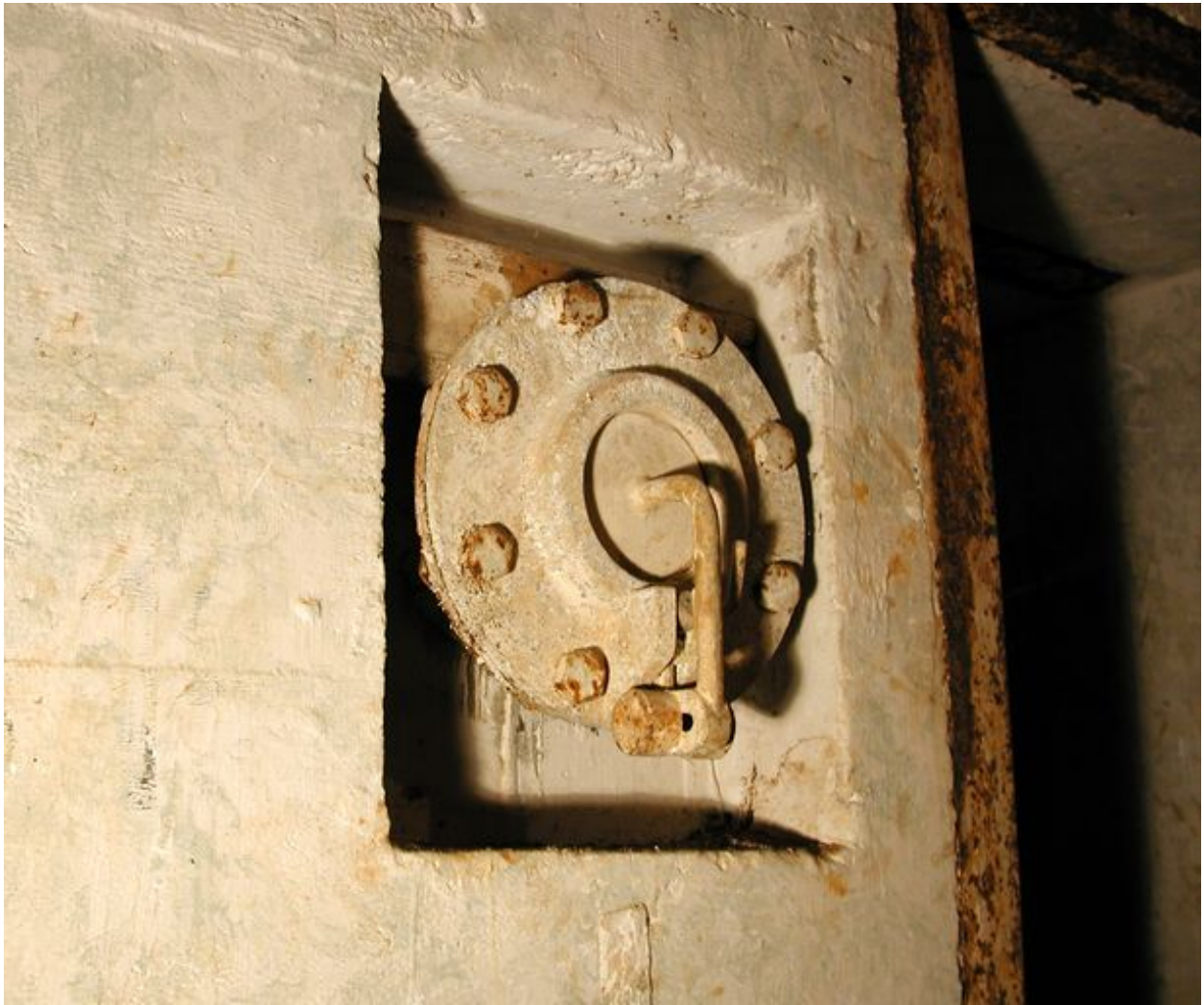
Clapet de surpression du sas étanche (modèle 4ML01)
