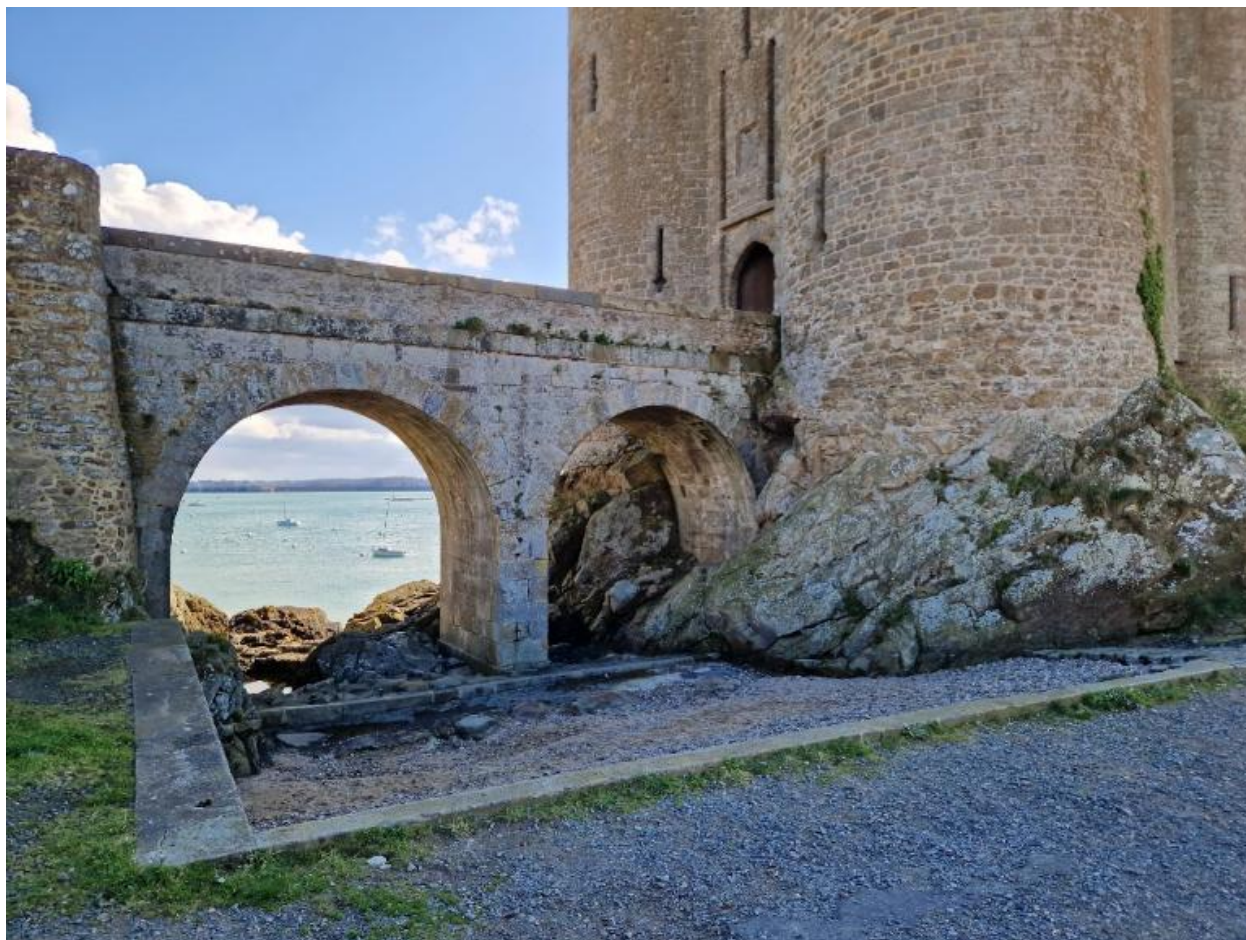
Vue générale du pont dormant de la tour depuis le nord
