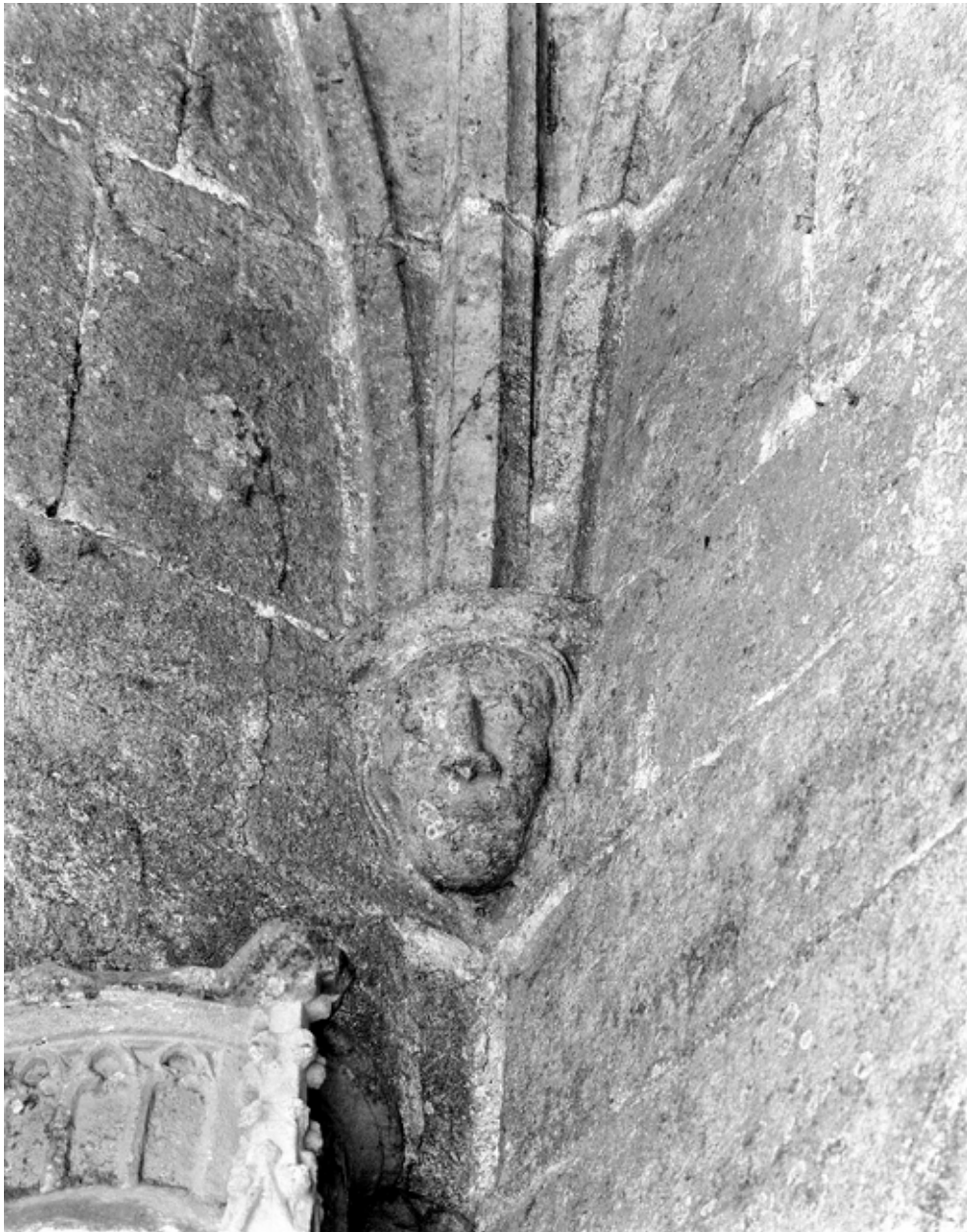
Porche sud, angle nord-ouest retombée de l'ogive sur un cul-de-lampe sculpté.
