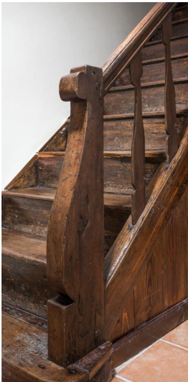
Logis ouest, vestibule d'entrée, détail de la fin de la rampe d'escalier
