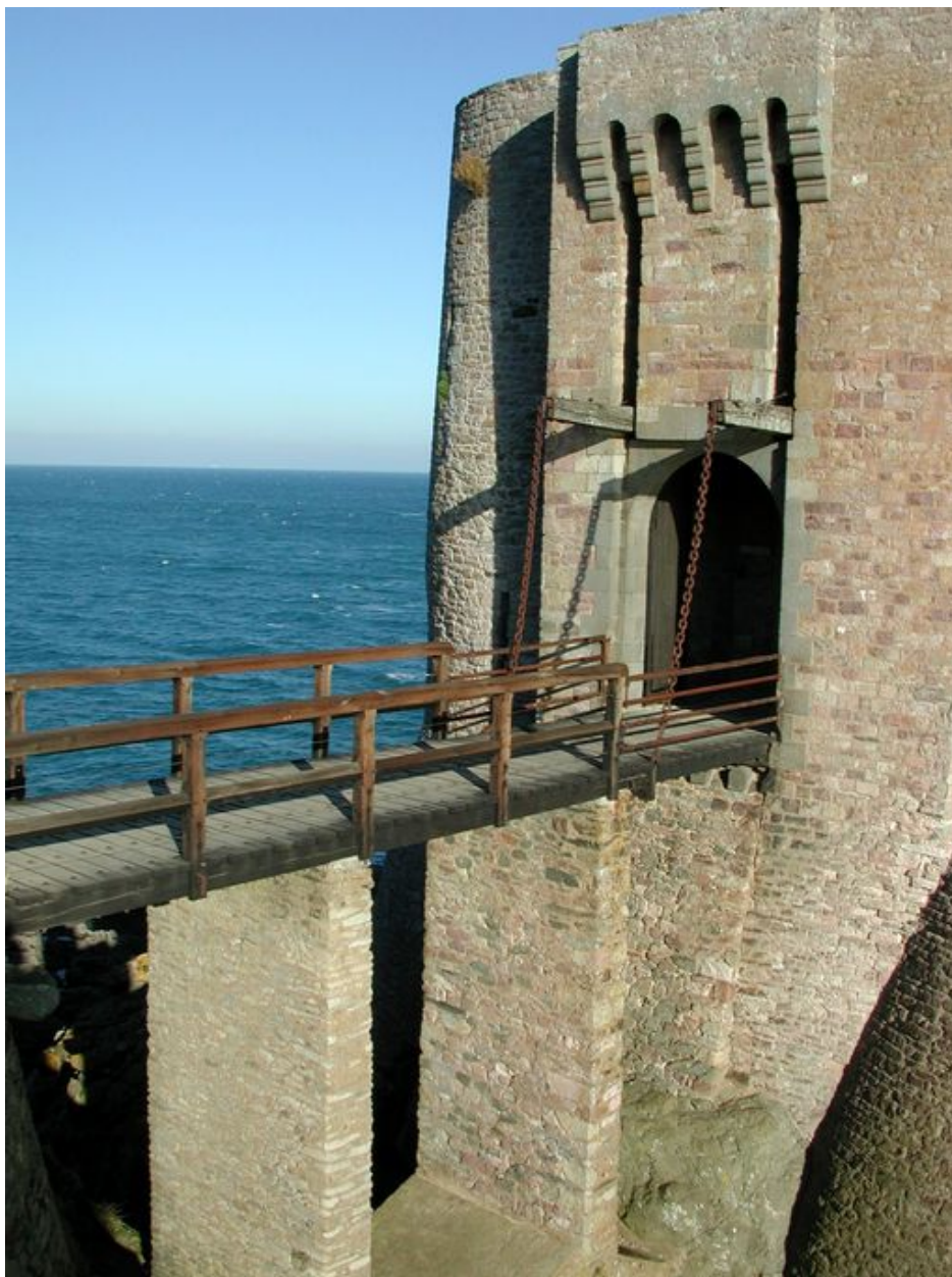
Vue du Fort La Latte
