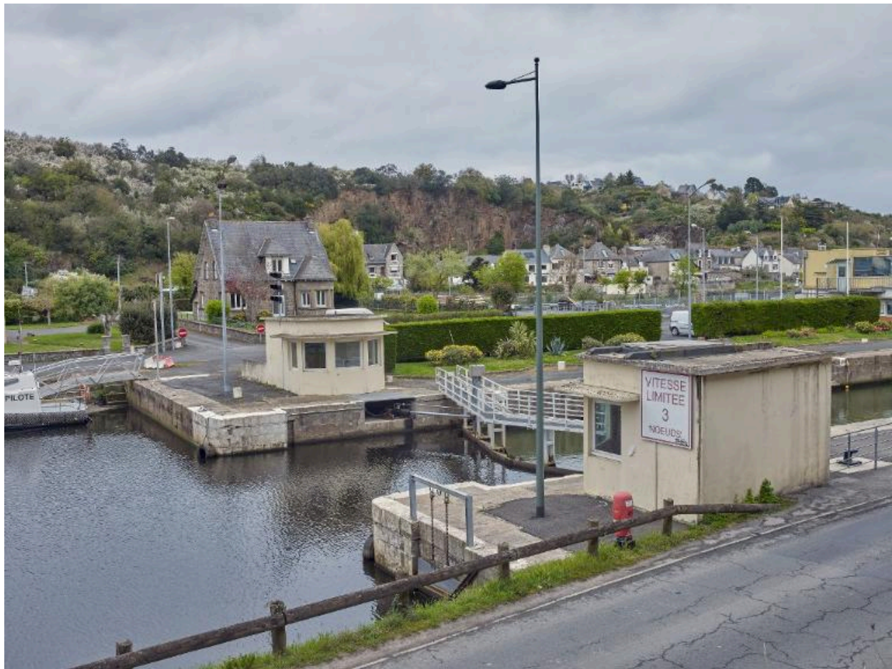
Vue des deux postes d'écluse en amont
