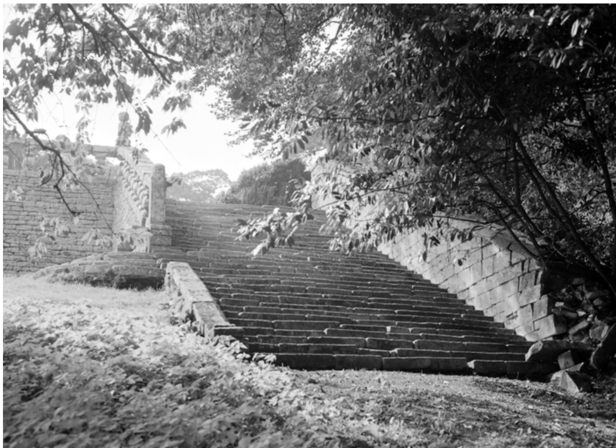
Terrasse, escalier : vue générale est.
