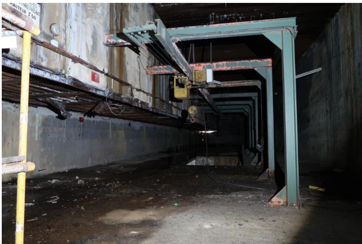
Vue de l'extension nord-ouest : portique et treuil du troisième étage servant de magasin
