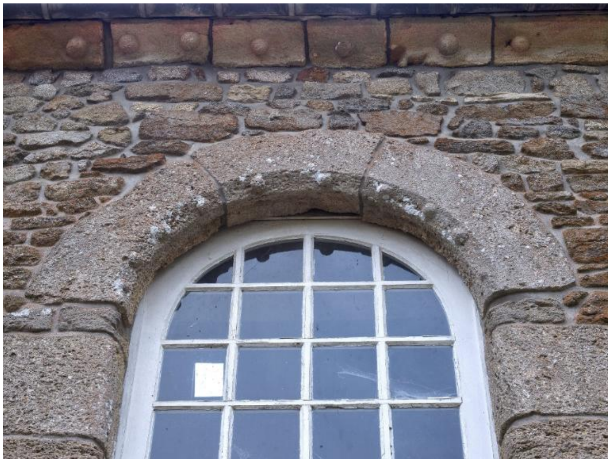
Façade est. Porte haute en pierre calcaire des Faluns. Détail du plein cintre et de la corniche ornés de boules
