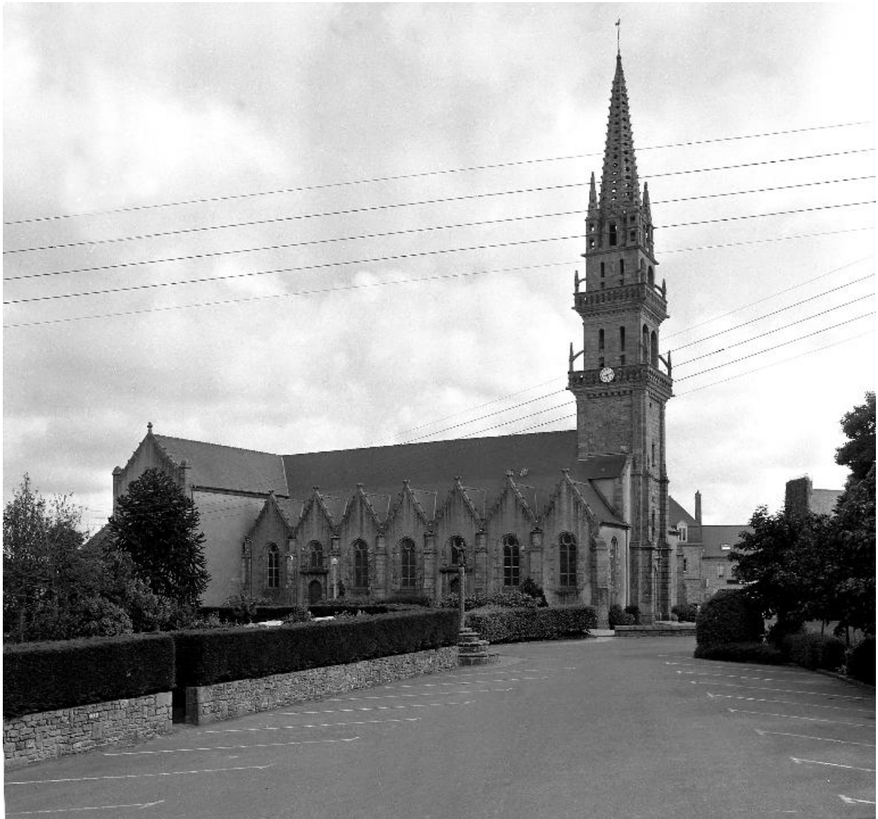
Église : élévation nord prise du nord-ouest (état en 1986)
