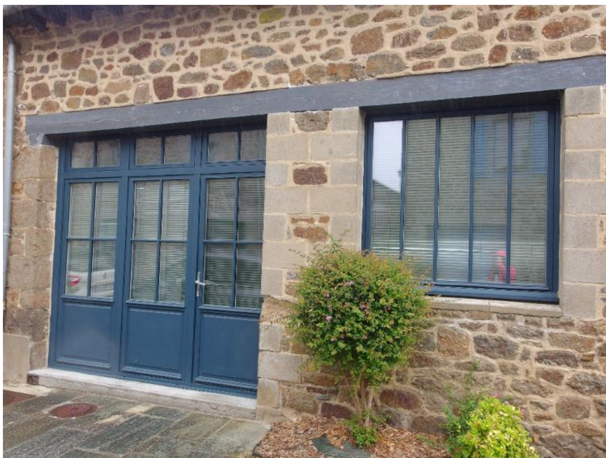
Détail de la façade ouest
