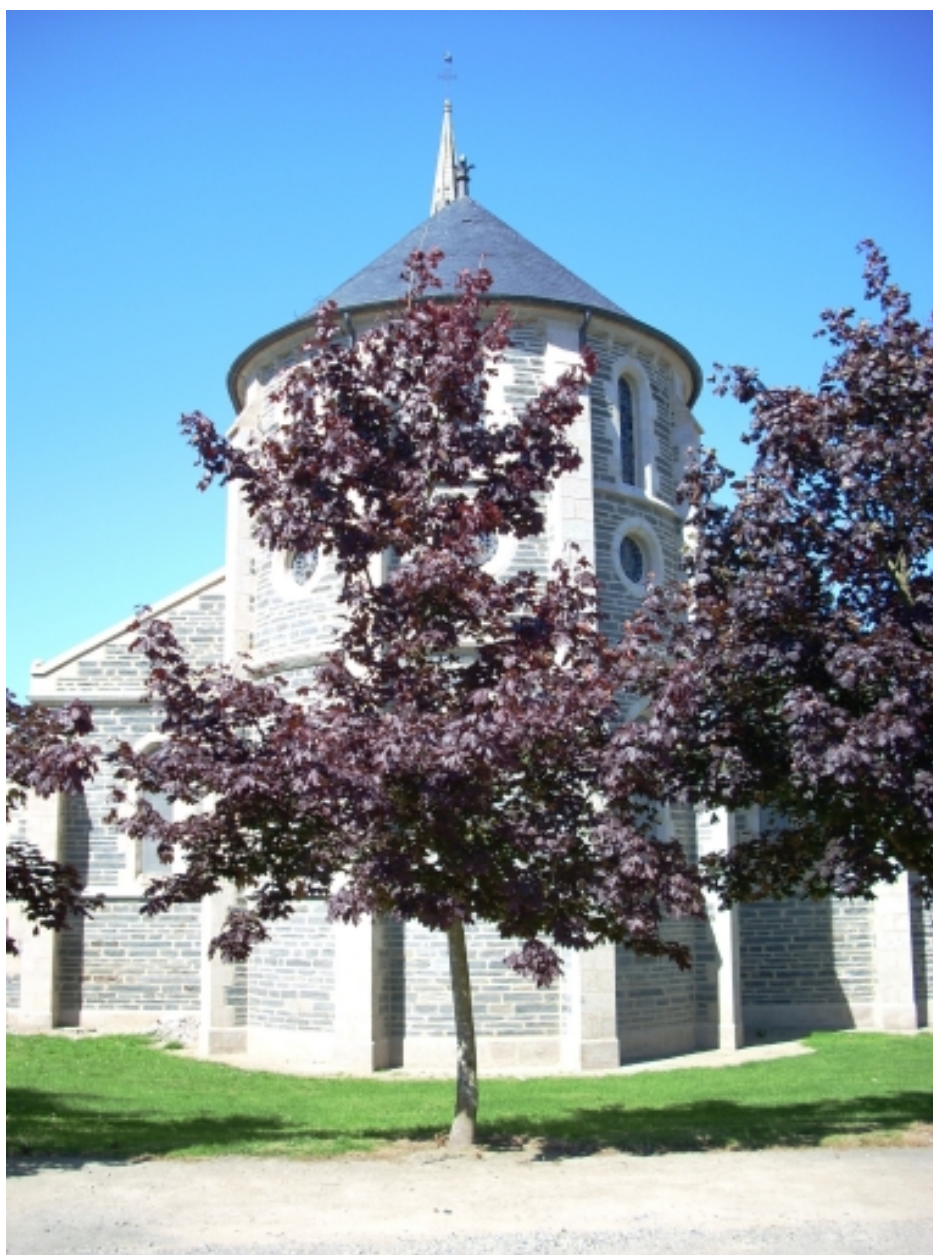
Taulé, église paroissiale Saint-Pierre : élévation est
