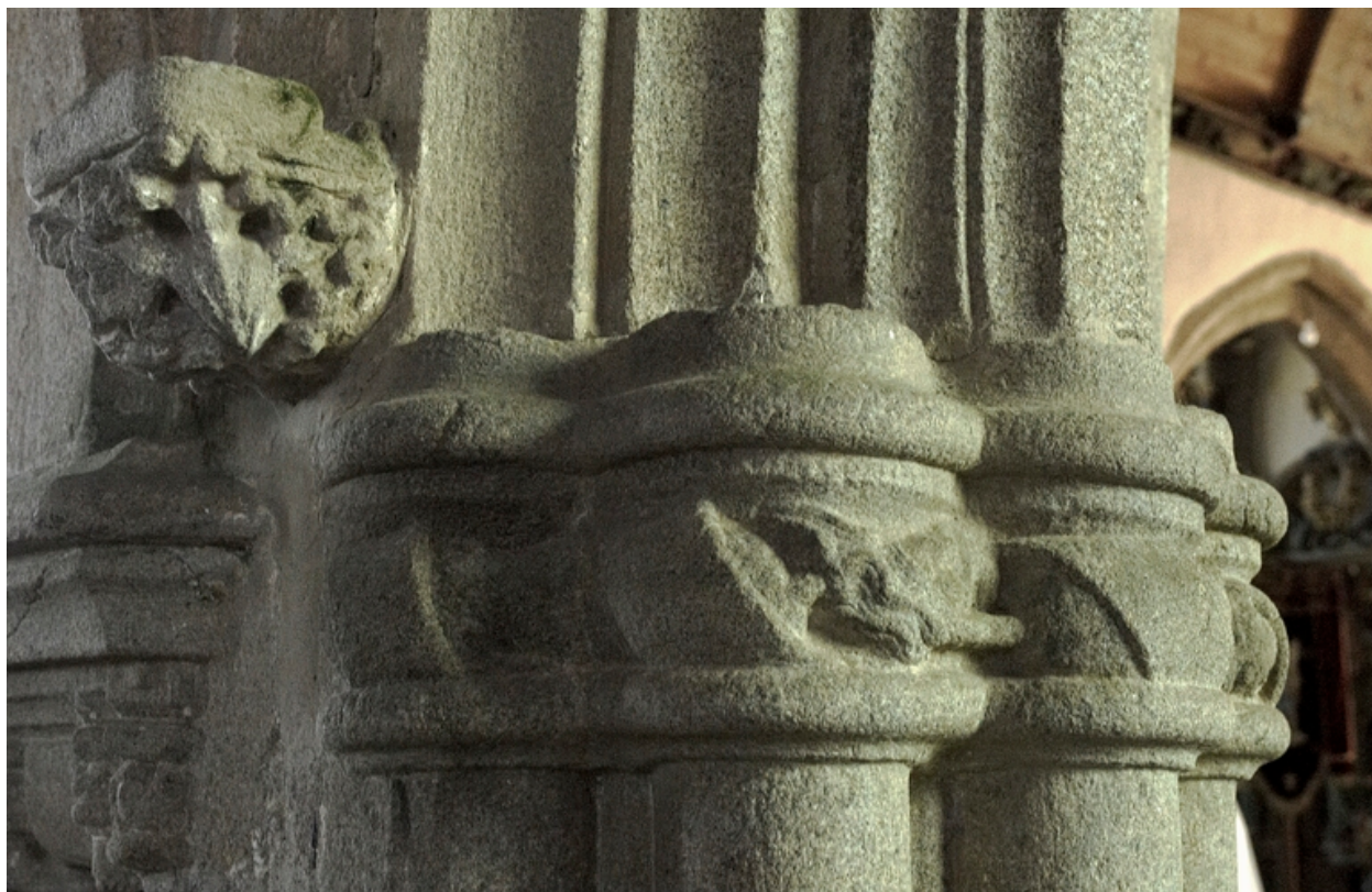
Chapelle de la commenderie, pile ouest, partie sud
