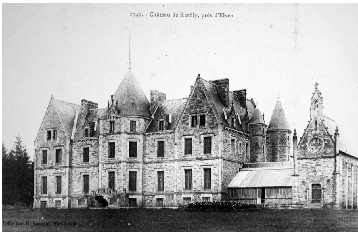
Vue générale des élévations sur jardin
